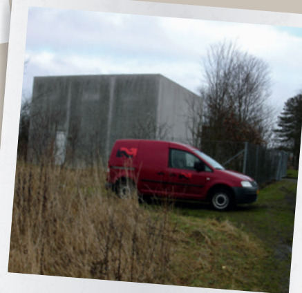
Tønder Vest central. Opført i 1995 i forbindelse med nedlæggelse af kedelcentral på Tønder Tekniske Skole
