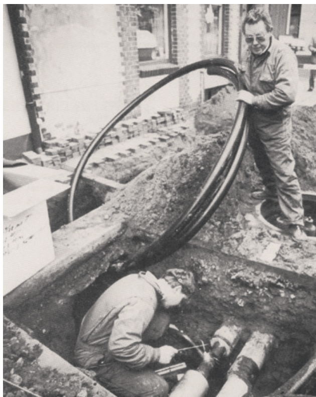
Tilslutning af ny forbruger i Spikergade
