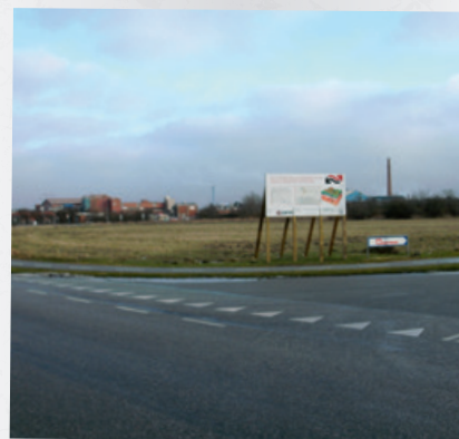
Geotermigrunden. Tønder Fjernvarmes fremtidige varmeforsyning
